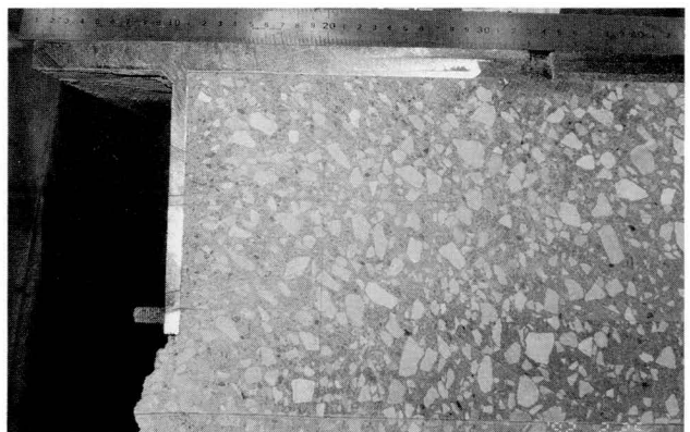
写真-8 切断面のコンクリート充填状況
