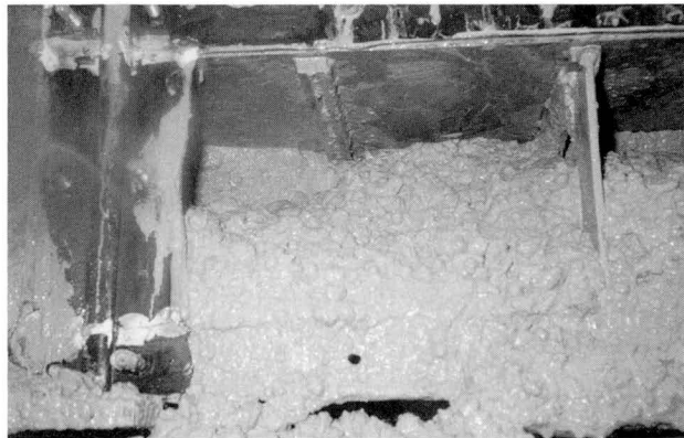
写真-6 上面鋼板にも充分充填されている状況
