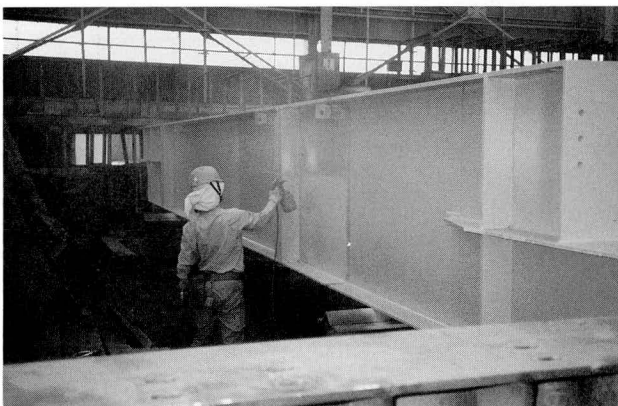
写真-5 大型供試体塗装
