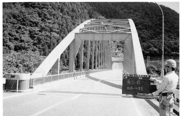
写真-I 着工前写真
