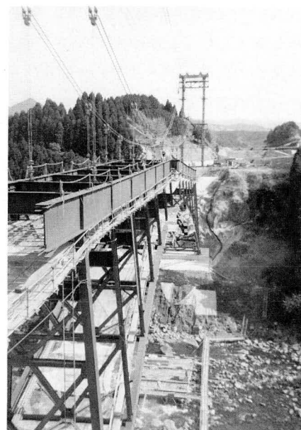
写真-2 アーチ材の架設(桁部分)
