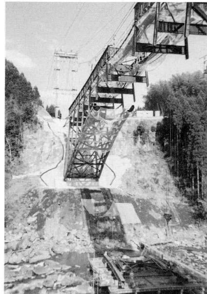
写真-1 アーチ材の架設(アーチ部分)
