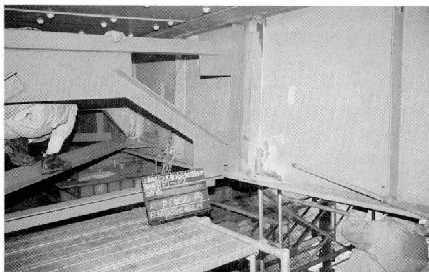
写真-4 横構・対傾構の新設
