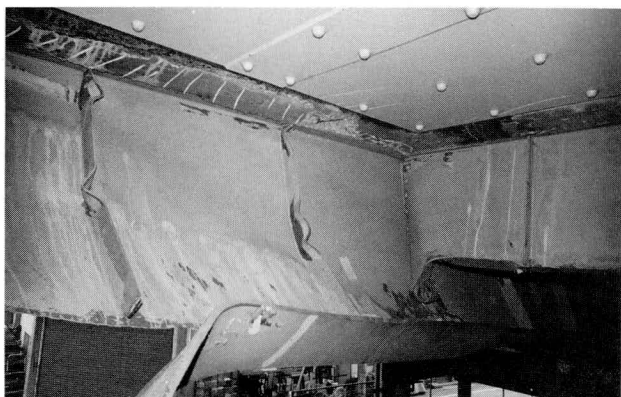
写真-2 GB桁下フランジ
