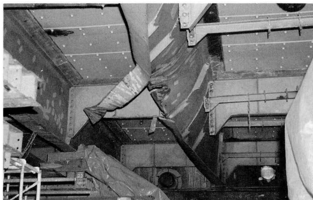
写真-1 GB桁下フランジ
