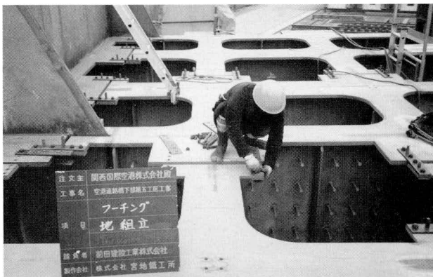
写真-3 フーチングブロック連結部形状
