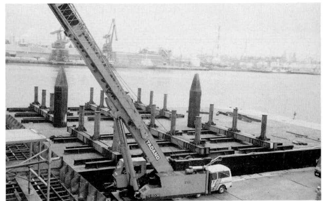
写真-8 バージ上架台
