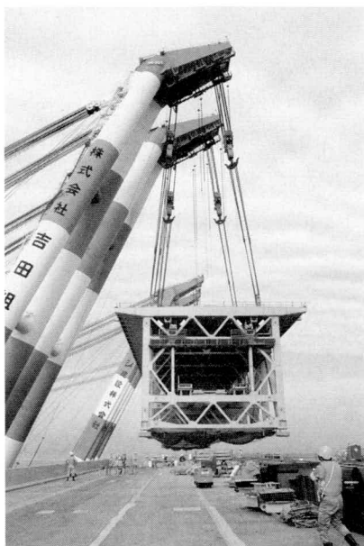
写真-4 No.1ブロック架設
