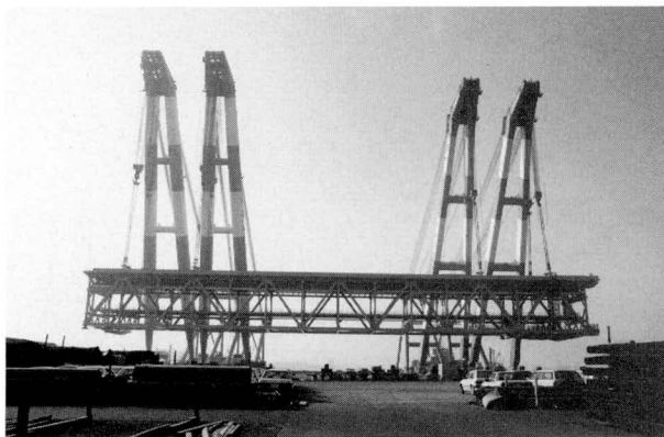
写真-1 No.1ブロック浜出し
