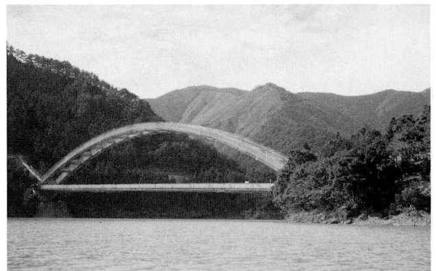
写真-2 新橋写真
