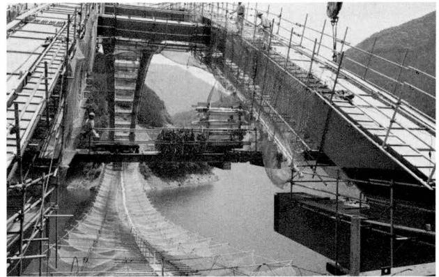
写真-5 斜吊材の取り付け(ケーブル架設)
