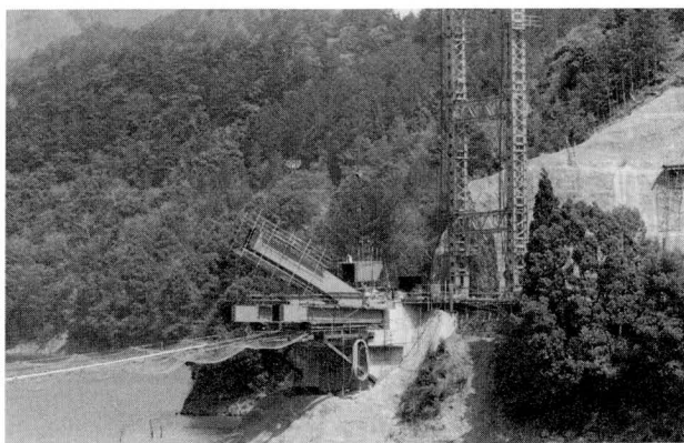
写真-4 端部架設写真(斜ペント)
