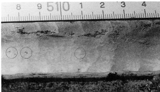
写真-4 浸透探傷写真
