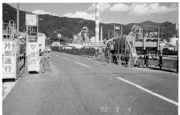
写真-7 作業中の路面占有状況
