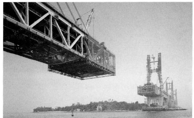
写真-1 長大吊橋の移動足場防護工
