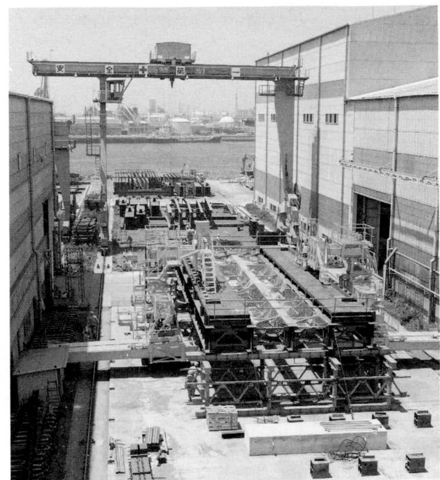
写真-5 伸縮フレームを開いた状態での走行テスト
