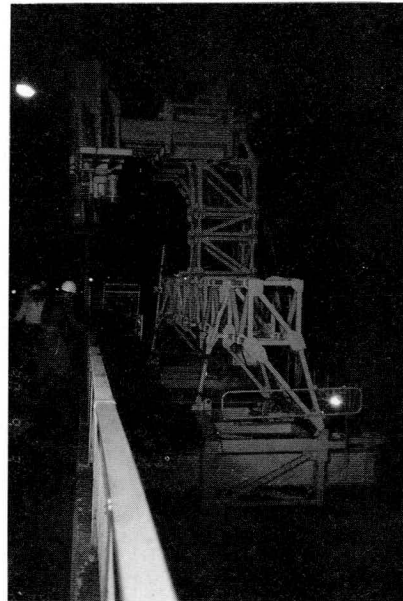
写真-6 クレーンによる据付作業
