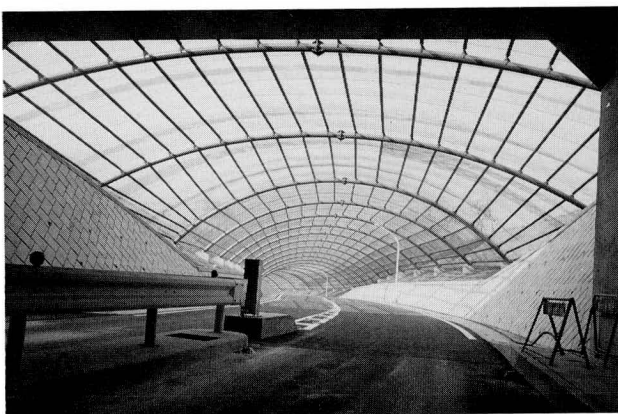
写真-1 完成状況(カルバート部側)
