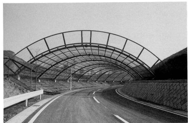
写真-2 完成状況(④通りを望む)
