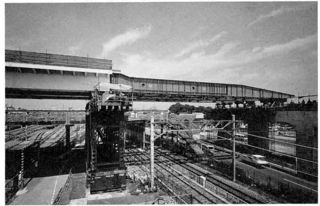
写真-1 SL桁送出し状況
