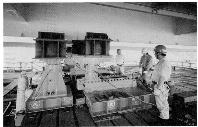
写真-2 送出し設備
