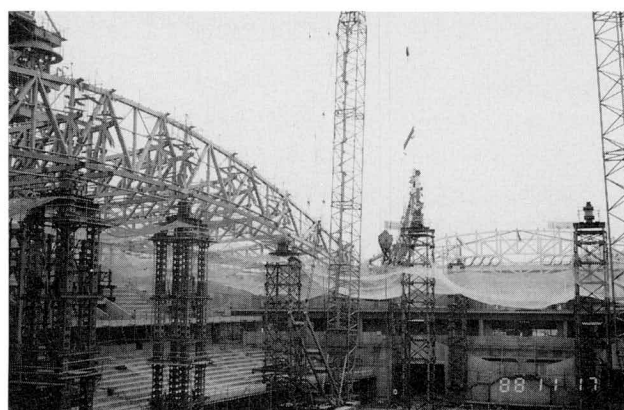
写真-2 Aアーチ架設状況
