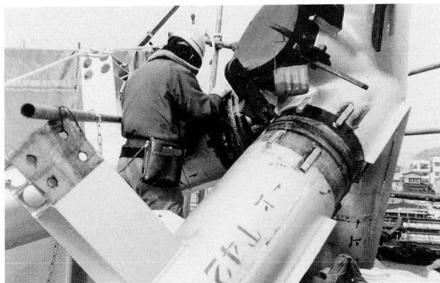
写真-13 現場溶接完了状況
