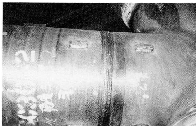
写真-3 試験体溶接完了状況
