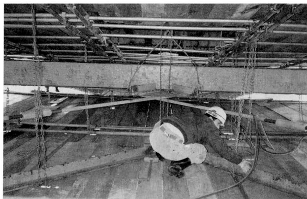
写真-4 仮設設備状況
