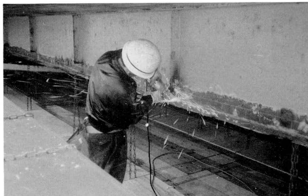
写真-5 直接サンダー作業状況
