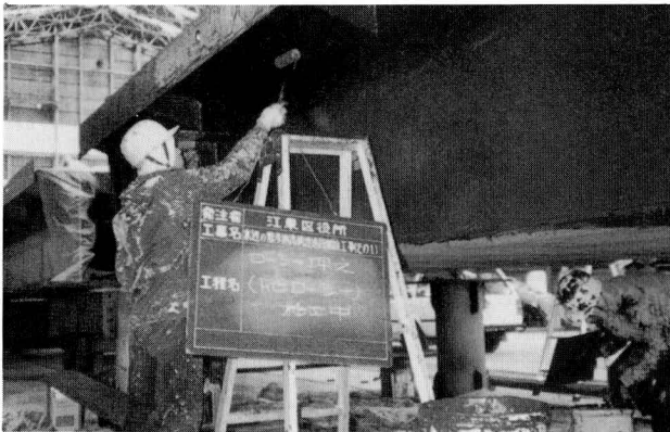
写真-4 塗装状況
