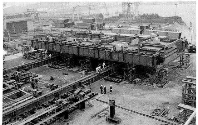
写真-1 工場での格子桁の横取り試験
