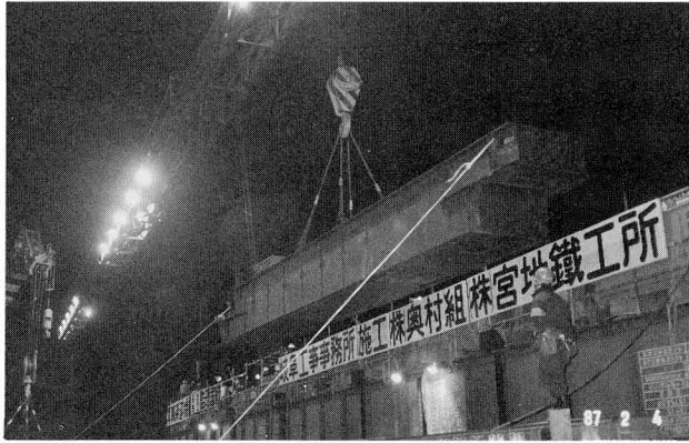
写真-2 軌条桁の設置
