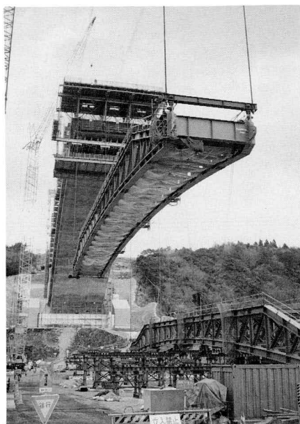
写真-8 Aライン、リフトアップ状況
