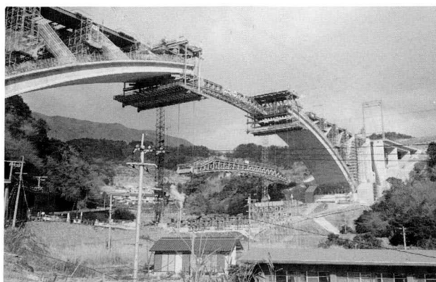
写真-9 Aライン、リフトアップ完了状況
