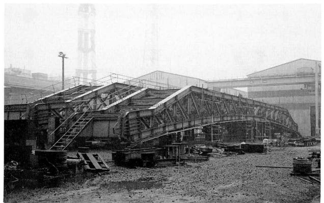
写真-2 メラン材の仮組立状況
