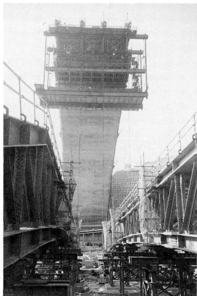
写真-6 リフトアップ設備全景
