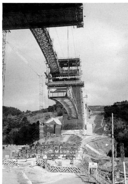
写真-10 Bラインリフトアップ状況
