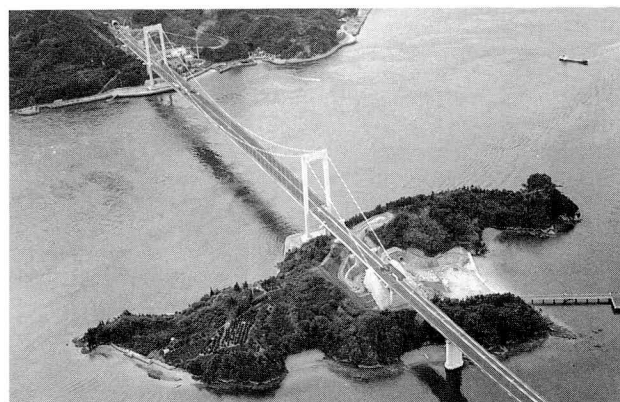
写-3 大島大橋全景
