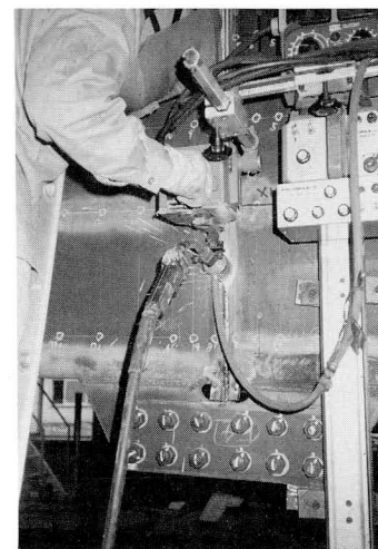
写-4 立向上進全自動によるウェブの溶接
