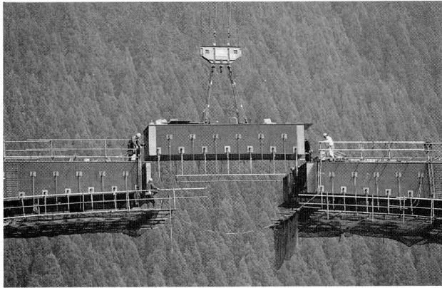
写真-7 アーチ部材の閉合(第4橋)
