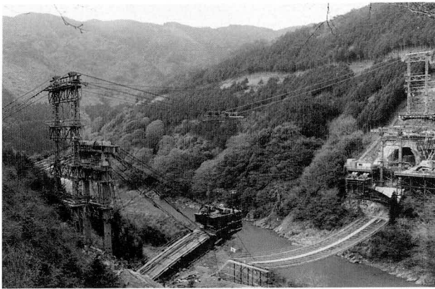
写真-4 第4橋のアーチの架設
