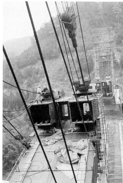
写真-3 第4橋隅角部断面の架設
