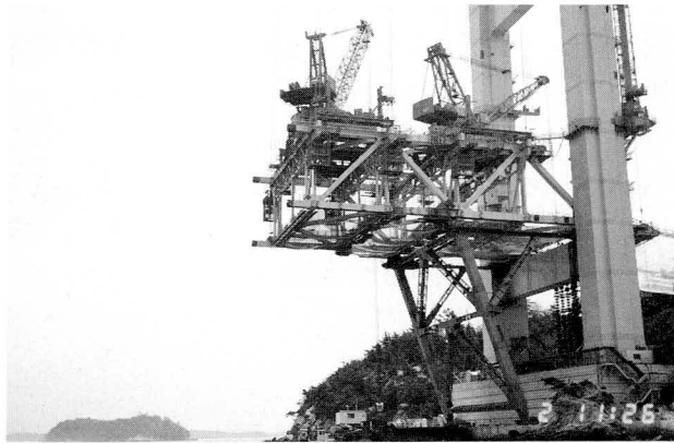
写真-8 3Pトラベラクレーン設置状況
