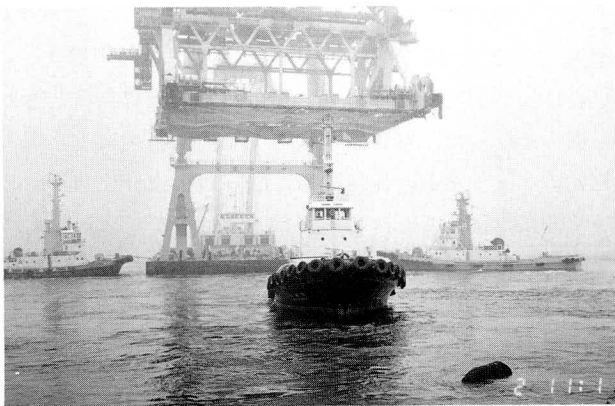
写真-5 3P塔付ブロック 進入開始の状況
