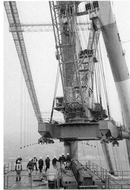
写真-7 3P張出径間用トラベラクレーンの設置
