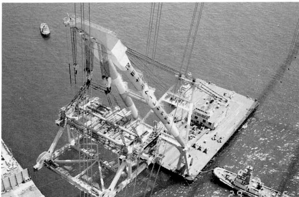
写真-4 2P塔付ブロック 2P前面に進入
