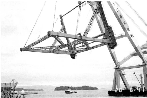
写真-3 2P塔付ペント・吊運搬して2P到着
