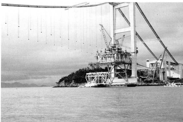
写真-9 3P前面に係留した台船
