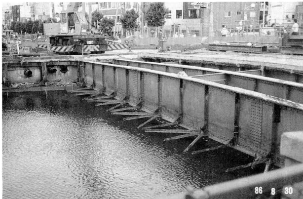
写真-1 撤去前の状況
