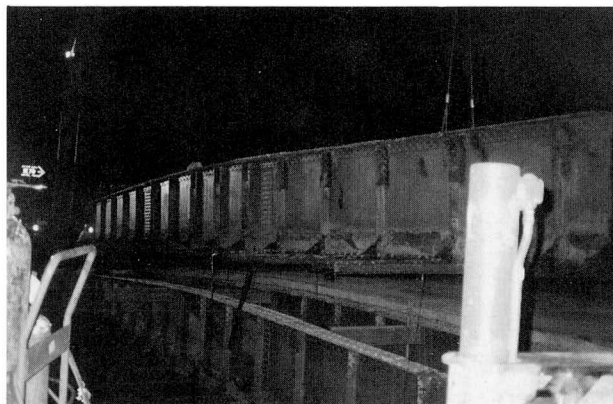
写真-8 試験桁の吊上状況
