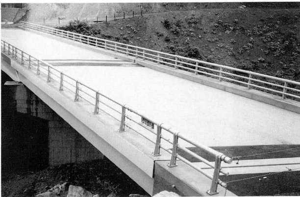
写真-9 完成状態
