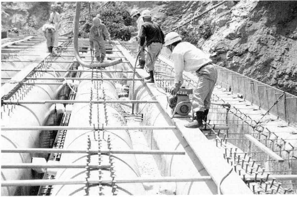
写真-8 コンクリートの充填
