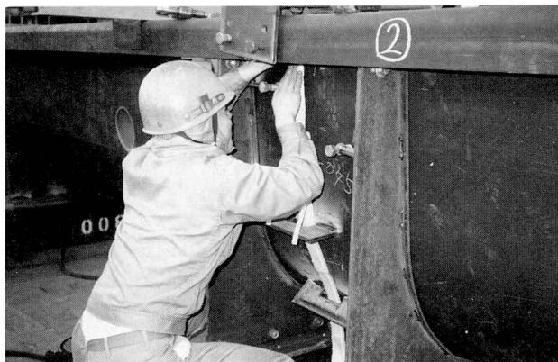
写真-4 裏当材取付
