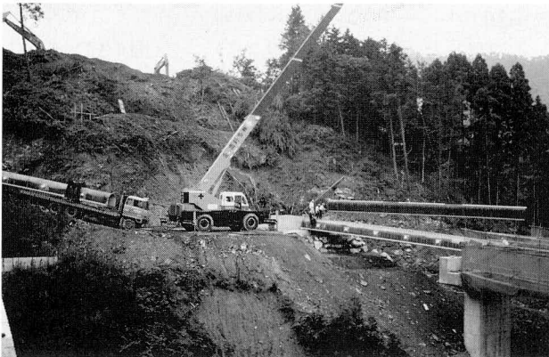
写真-7 桁架設 (40t油圧クレーン)
