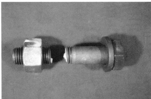
写真-3 破断高力ボルト
