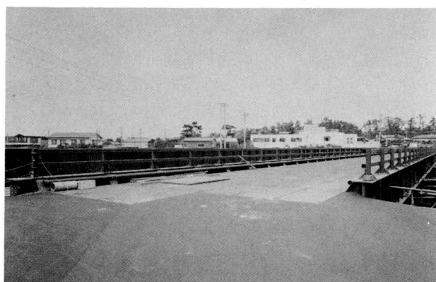
写真-3 下路式の施工例(西浜橋仮橋・神奈川県)
