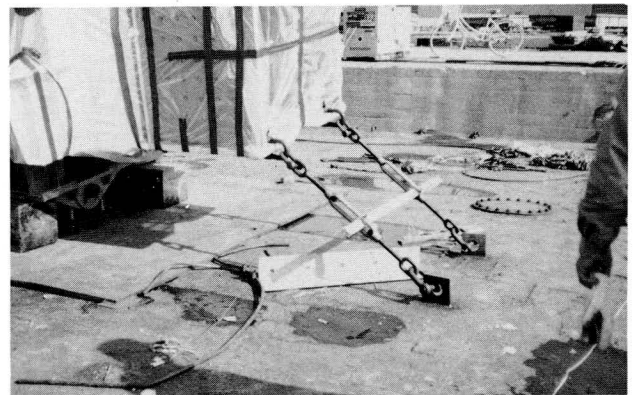
写真-6 台船へのラッシング状況
