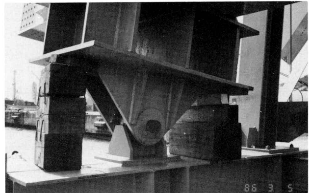
写真-5 下弦材受点の取合
