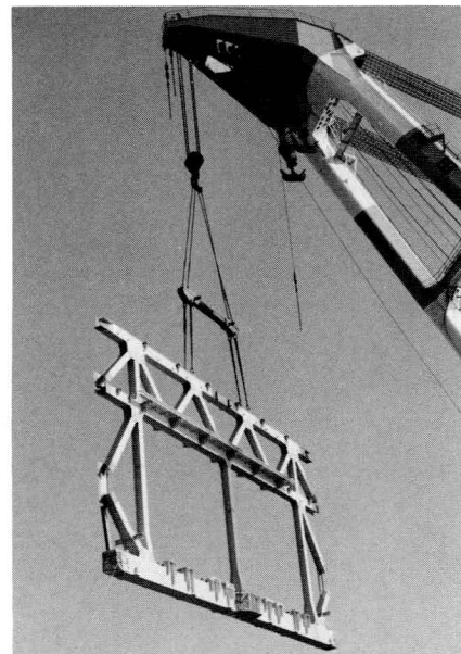
写真-2 床トラスの吊上状況
