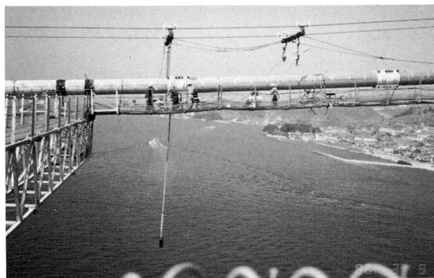
写真-15 ハンガーロープ架設
