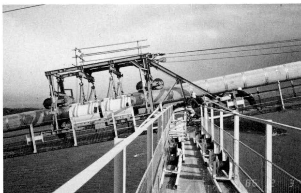
写真-13 ケーブルバンド架設
