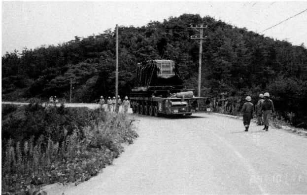
写真-2 トランスポーターによるサドルの小運搬
