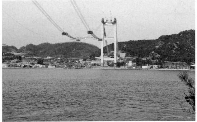
写真-7 中央径間床組立
