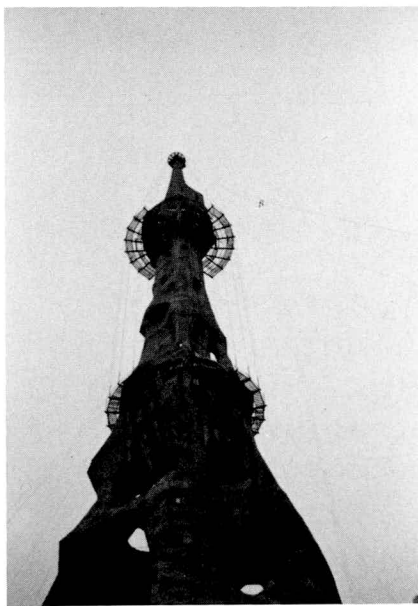
写真-4 キャリヤーによる構台の組立て
