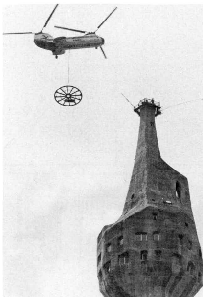
写真-3 ヘリコプターによる頂冠リング吊上げ
