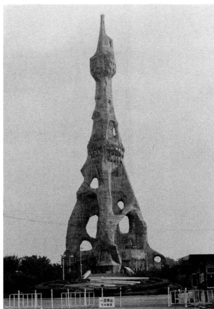
写真-1 化粧工事着工前の全景
