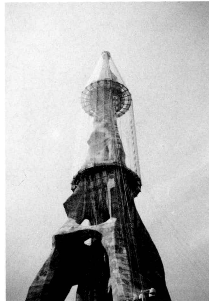
写真-6 作業足場外観
