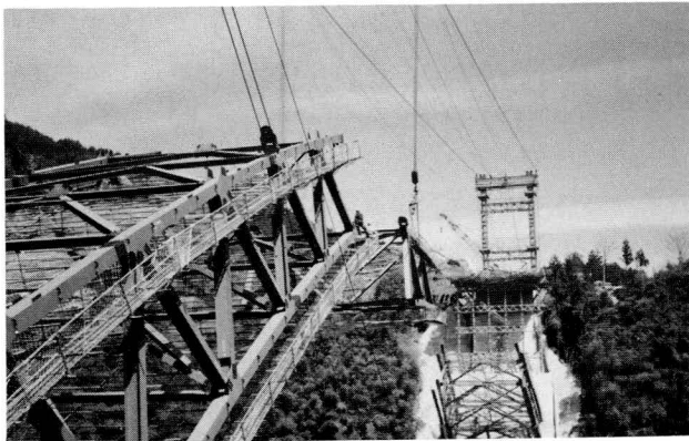
写真-1 アーチブロックの架設
