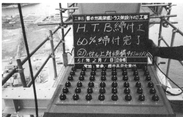
写真-2 1次締め完了後のマーキング状況
