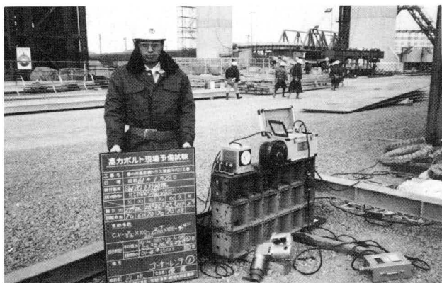
写真-1 現場予備試験 (狭部用コーナーレンチ)
