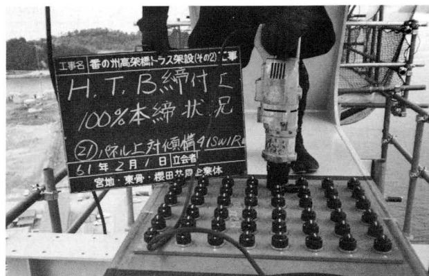
写真-3 本締め作業状況
