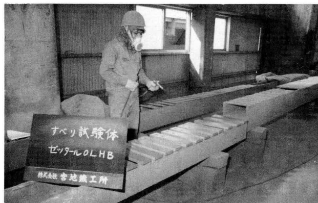
写真-1 塗装状況(厚膜型無機ジंकリッチペイント)
