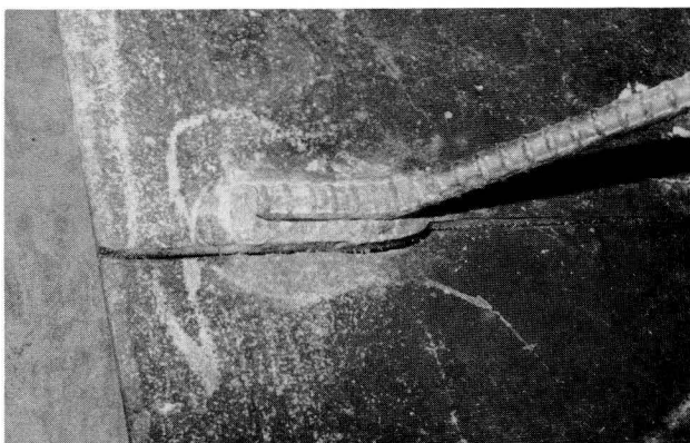
写真-4 疲労による破断箇所
