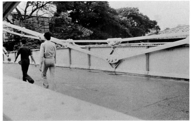
写真-5 チェーンの主桁への碇着
