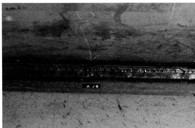
写真-5 リレーオート溶接棒継ぎ部外観形状
