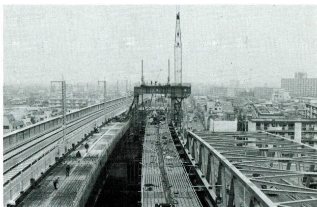
写真-5 通勤線桁降下
