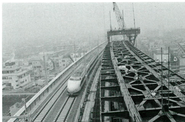
写真-7 ホームトラス降下
