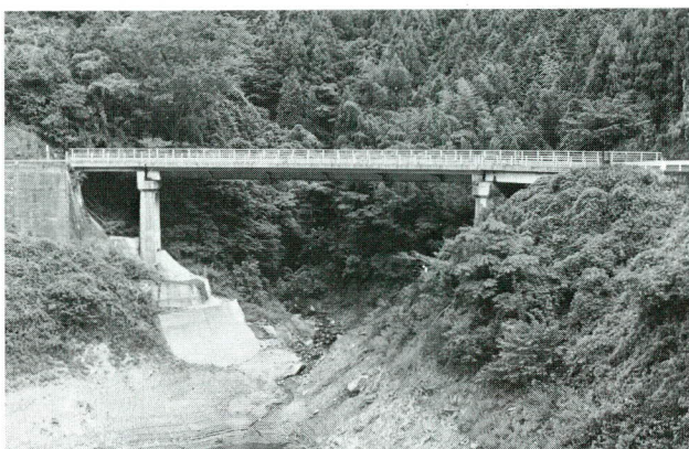
写真-1 着工前全景
