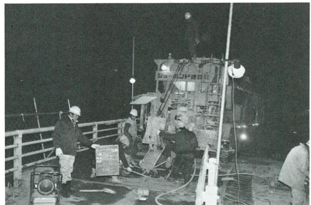
写真-6 超速硬コンクリートの打設状況
