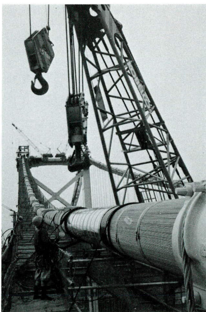
写真-7 盛替架設(その1)キャットウォークの開口
