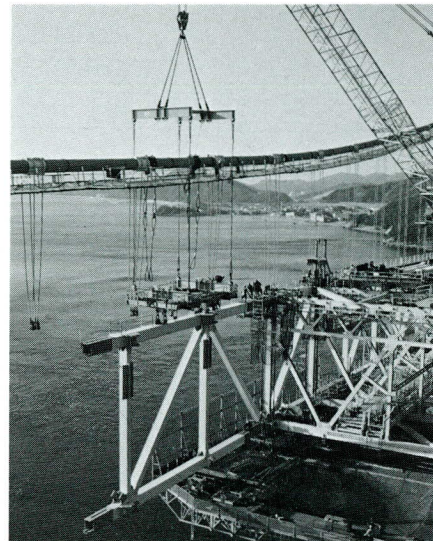
写真-8 盛替架設(その2)
