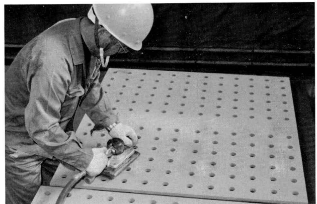
写真-2 接合面のサンダー削り
