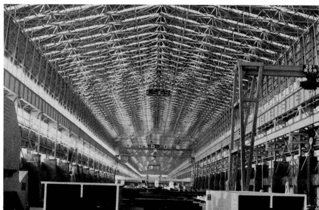
写真-4 塗装工場の温湿度表示(電光掲示)
