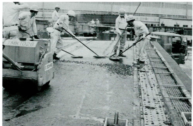
写真-3. 工場舗装
