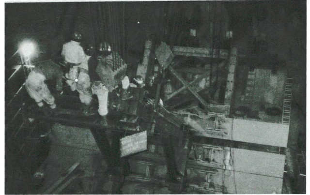
写真-12 手巻ウインチによる落込み状況
