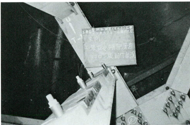
写真-17 受棚テフロン板施工
