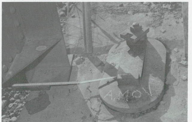
写真-11. PI橋脚上可動沓(A桁)の外観
