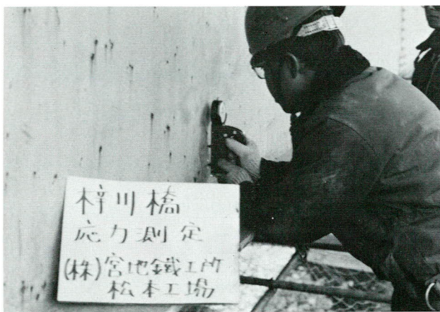
写真-12. ストレインメーターによる測定状況
