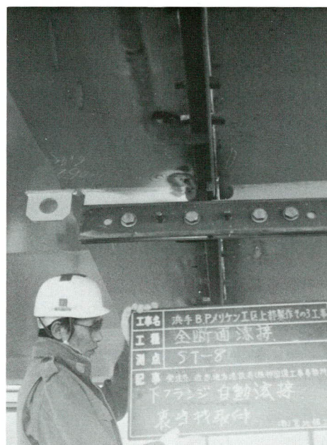
写真-5. 下フランジ裏当材取付状況
