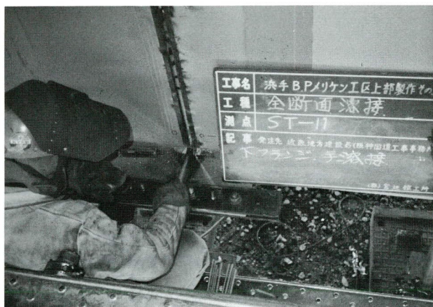
写真-3. 下フランジ両端部被覆アーク片面溶接
