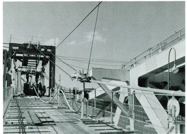
写真-3. 2P側塔付近P.W.S仮引き
