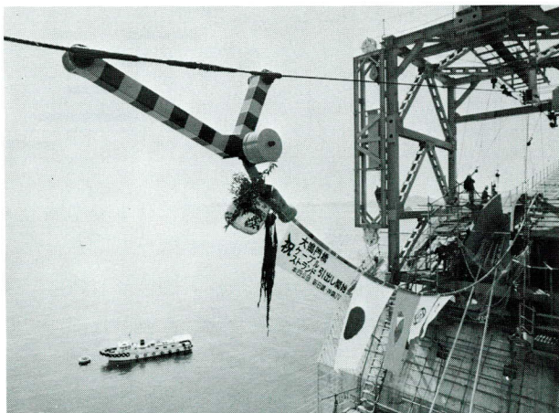
写真-2. No.1ストランド引出し
